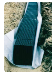
Przykładowa instalacja obejmująca jeden rząd modułów AquaBlok®
