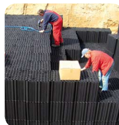
Przykładowa instalacja obejmująca kilka warstw modułów AquaBlok®
